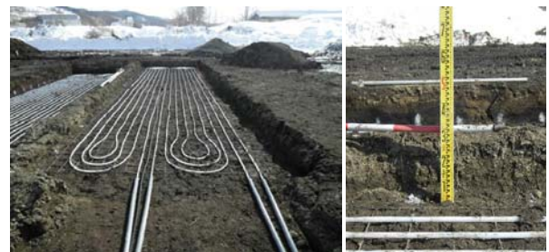
写真-3 採熱管布設 (実験A)
