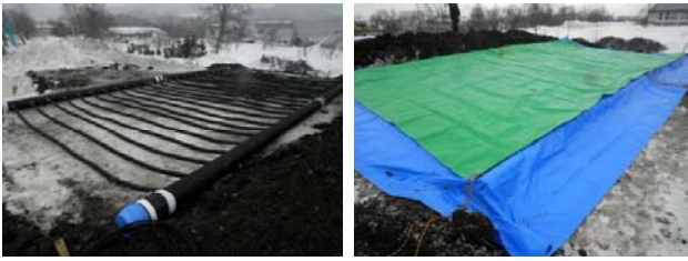
写真-5 採熱管敷設(実験C) 写真-6 シート設置状況
