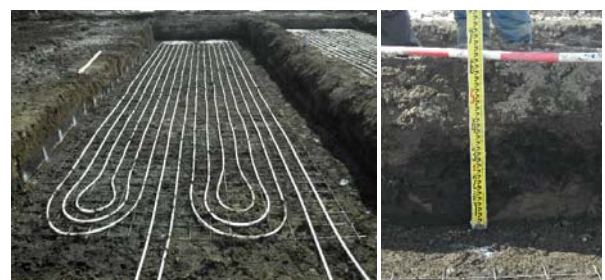
写真-4 採熱管布設 (実験B)
