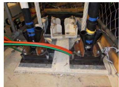
写-13 仮設鋼製ガイド
