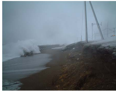
写真-3 被害事例1 A地区
