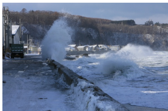
写真-2 海岸護岸への越波事例（網走港海岸護岸）
