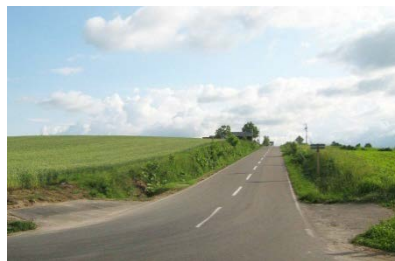
写真-5 自治体による郊外観光地における電線地中化事例（美瑛町提供）
