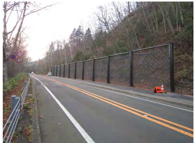
写真3 完成した土砂防護柵
