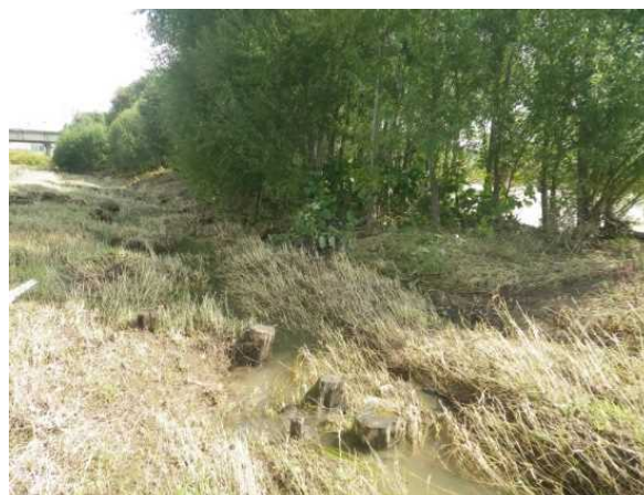
写真-1 掘削路造成前のalcove上流に堆積した砂州 2017年9月18日の降雨による増水後に砂州上流路跡に河川水が残る様子（2017年9月20日撮影）。
