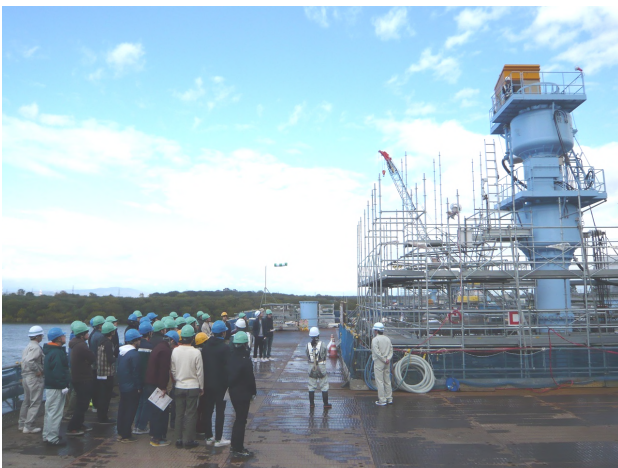
写真1 現場見学会の状況(R275新石狩大橋)
