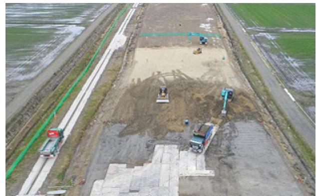
写真2 ICT土工施工状況
