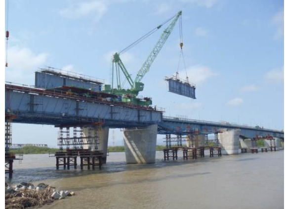
写真-9 鉄桁架設状況
