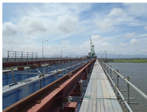
写真-5 軌条設置状況
