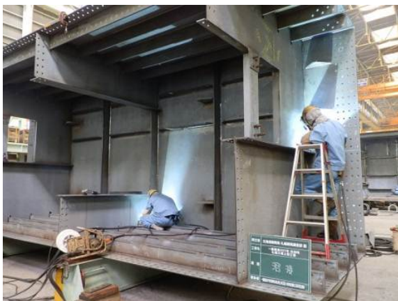
写真-2 工場製作状況
