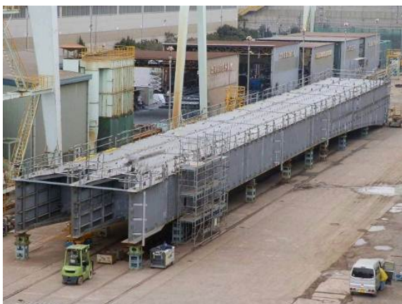
写真-3 仮組立状況
