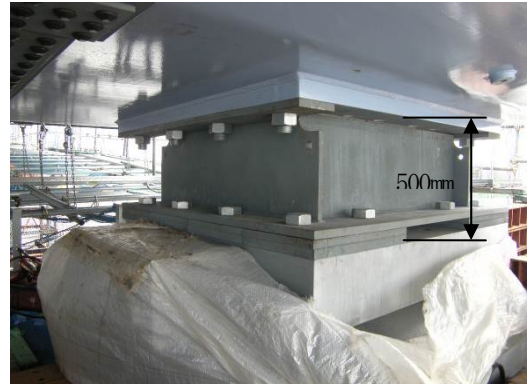
写真-12 支点部の嵩上げ架台
