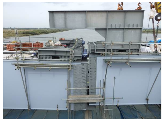
写真-13 セッティングビーム設置状況
