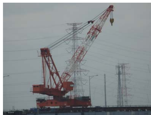
写真-6 650t級トラバークレーン
