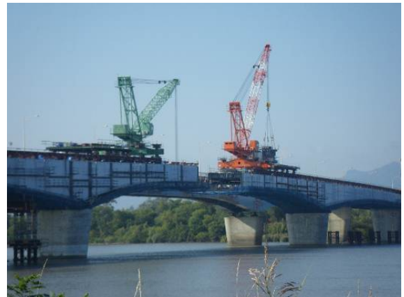
写真-11 箱桁張出架設状況
