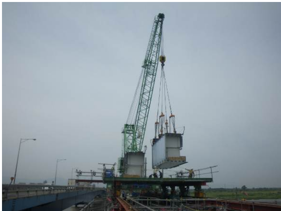
写真-8 運搬台車搭載状況
