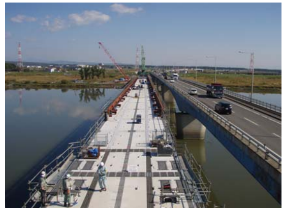
写真-17 桁閉合状況
