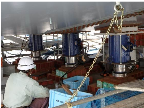
写真-16 降下用ジャッキ設置状況
