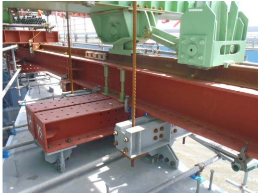
写真-7 トラベラークレーン固定金具
