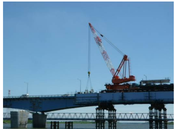
写真-10 箱桁架設状況
