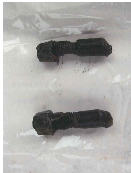
写真-3 ボルト・ナット腐食状況 (履歴番号④)
