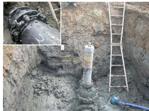
写真-6 開削調査状況 (SW-2 地点)
