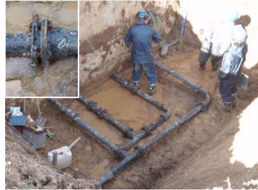
写真-8 開削調査状況 (K 地点)
