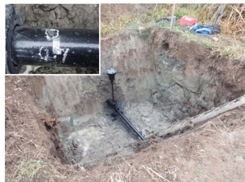
写真-5 開削調査状況 (UH-2 地点)
