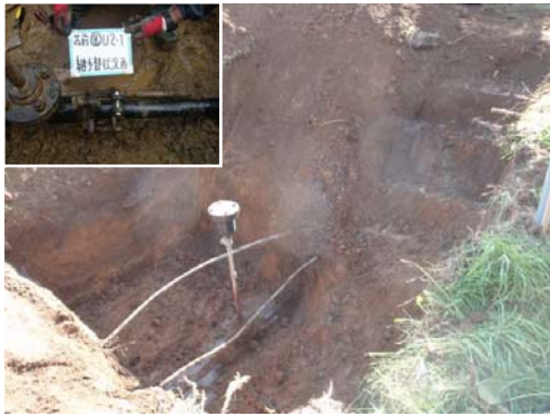
写真-7 開削調査状況 (U2-1 地点)
