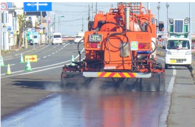
写真-2 フォグシール施工状況 (ディストリビュータ)
