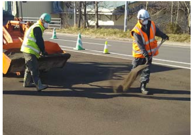
写真-4 砂散布状況
