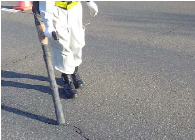
写真-1 舗装路面の清掃状況
