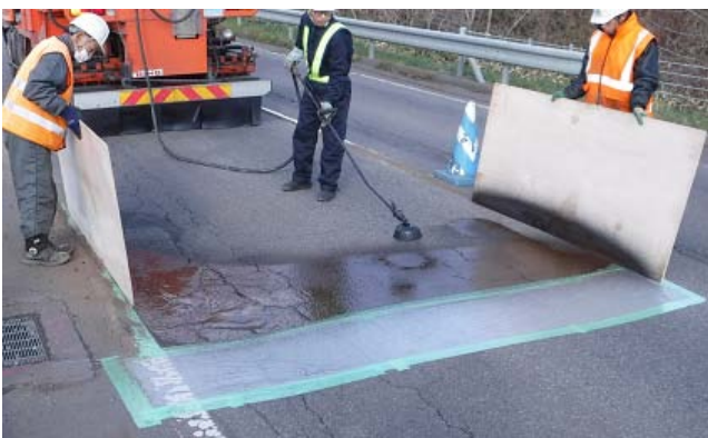
写真-3 フォグシール施工状況 (エンジンプレイヤ)
