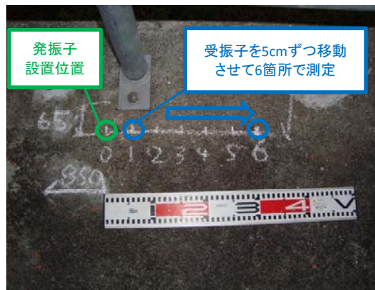
写真-5 表面走査法による調査状況(C樋門)
