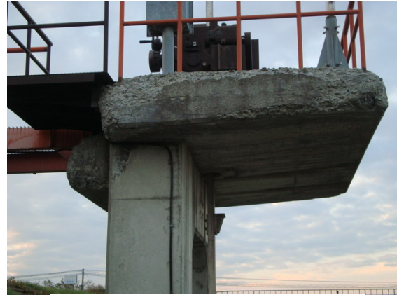
写真-3 D樋門の状況
