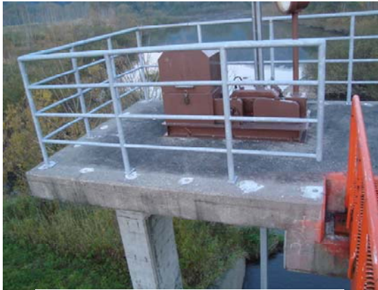
写真-2 C樋門の状況
