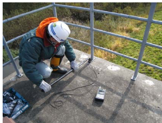
写真-6 アンカー定着強度確認調査の実施状況(C樋門)
