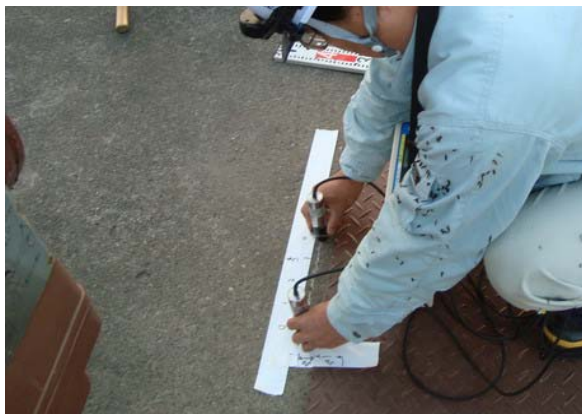
写真-4 表面走査法による調査状況(B樋門)
