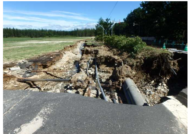
写真-4 農業用用水路の被災調査状況
