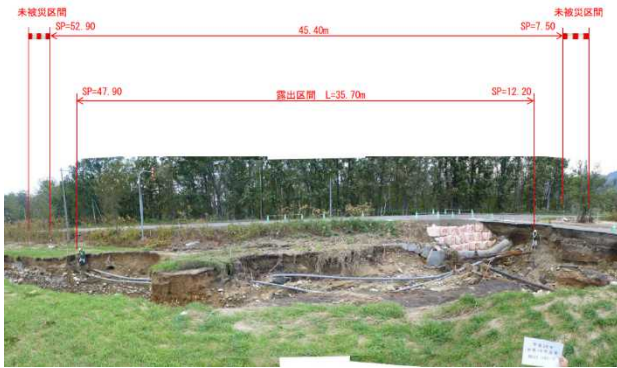
図-4 被災状況写真撮影方法
