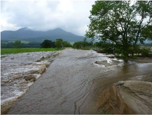
写真-2 円山頭首工へアクセスする町道の状況
