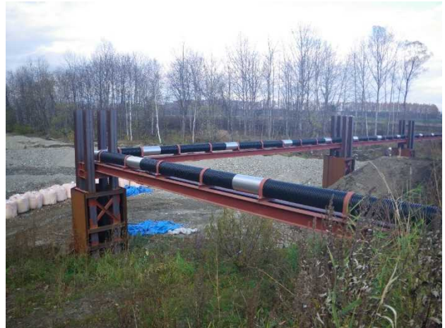
写真-5 応急仮工事における水管橋の状況
