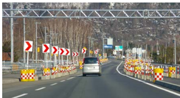
写真-3 補助標識の過剰な設置と考えられる例
