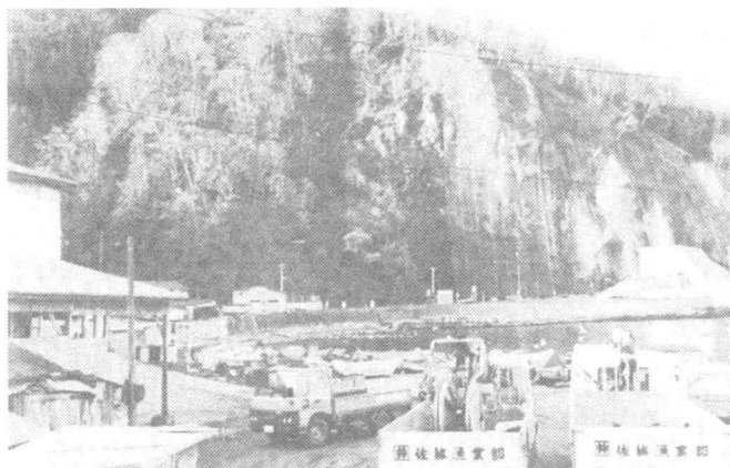
写真-1 現況写真
