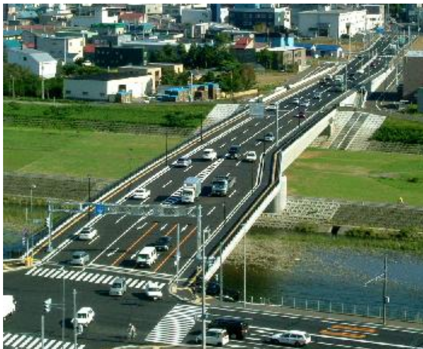
写真－1 平和大橋外観
