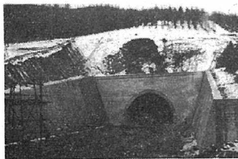
写真 30—2 豊浦隧道豊浦側より
