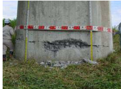
図 1-3 P13 橋脚柱の被災状況
