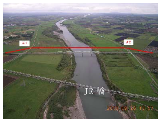
図 2-3 架橋位置の状況
