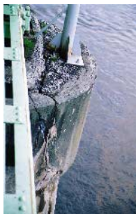
図 1-2 P8 橋脚橋座の被災状況
