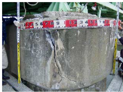
図 1-2 P8 橋脚橋座の被災状況
