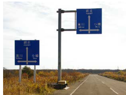
写真-8 片持式と路側式（歩道あり）の設置状況
