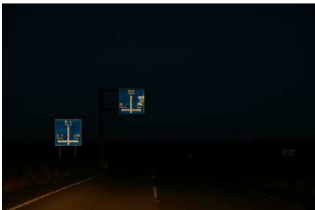
写真-12 夜間の視認性確認状況(前照灯下向き)
