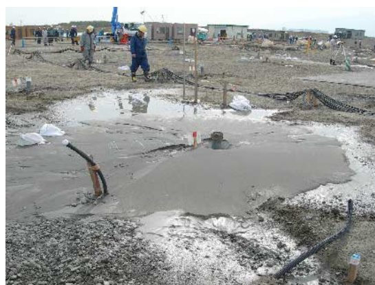
写真-3 液状化による憤砂
