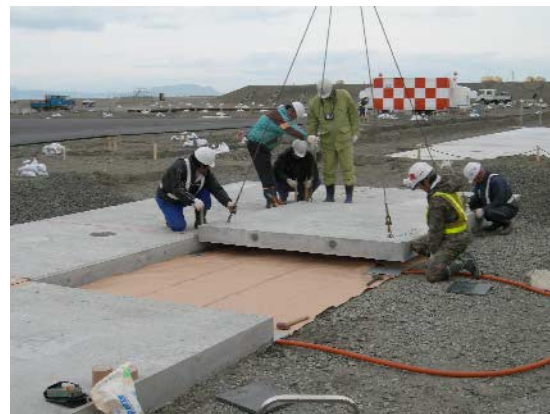
写真-2 プレキャスト版の敷設状況
