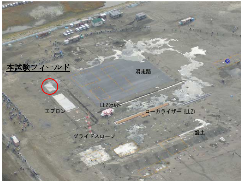
写真-1 石狩湾新港西地区 実験フィールド
