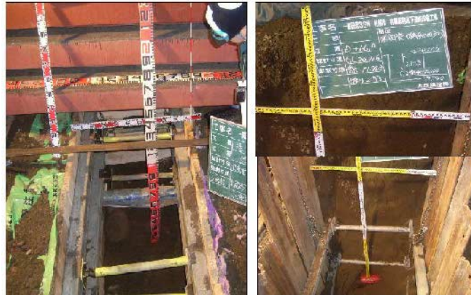
写真-8 埋設管確認状況
