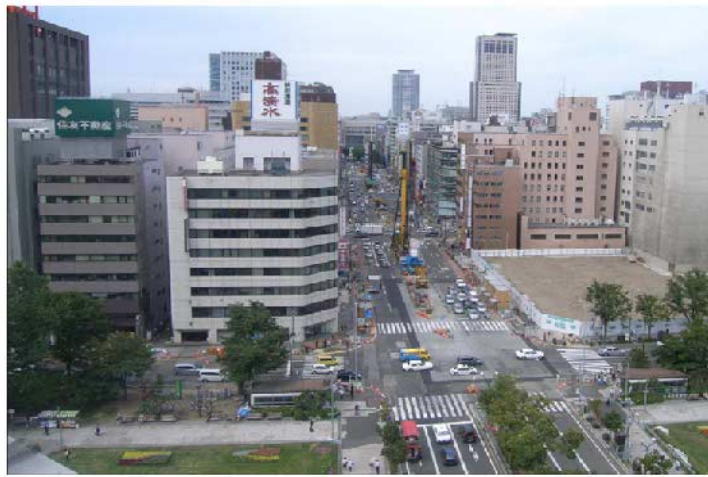
写真-1 昼間施工箇所全景 (作業休止中)
