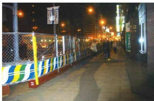
写真-3 フェンス設置状況
