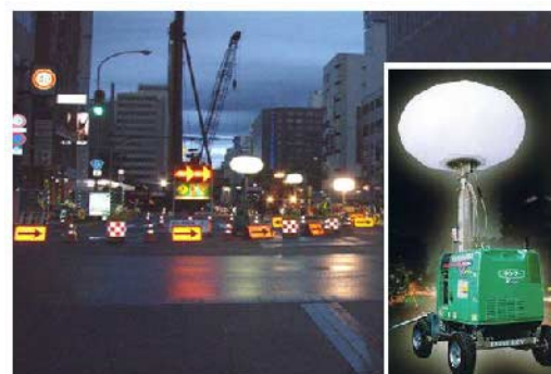
写真-4 バルーンライト設置状況
