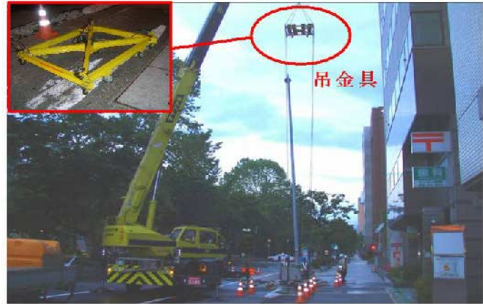
写真-7 街路灯撤去状況
