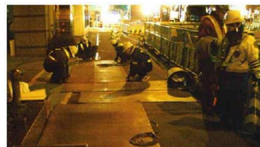
写真-6 ヒーティングマット設置状況
