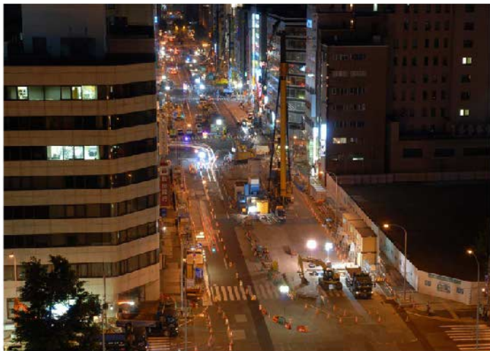
写真-2 夜間施工箇所全景 (作業中)
