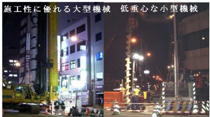
写真-9 杭打機械施工状況
