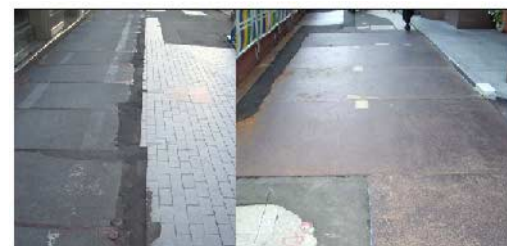
写真-5 覆工板・敷鉄板による仮復旧
