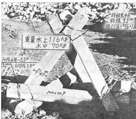
写真 52-1 コンクリート三基枠
