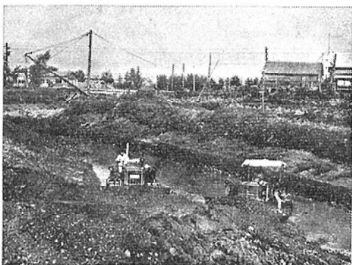
小松D50ブルドーザ2台による掘削作業
