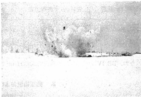
写真 69-6 火薬抜根の作業状況
