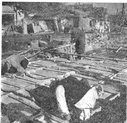
写真 11-1 真空マットの取付け
