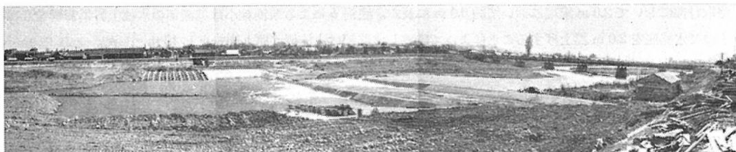
写真 42-1 床固メ全景写真
