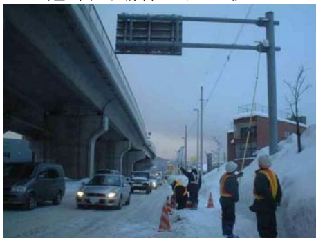
図-1 人力による雪下とし作業状況
