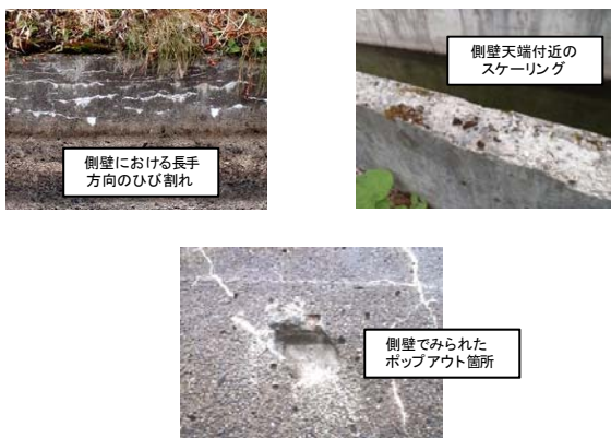
図-16 用水路における凍害劣化の形態
