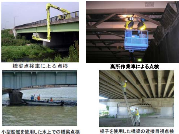
図-6 橋梁点検状況
