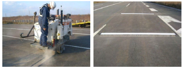
写真-2 注意喚起手法の施工状況
