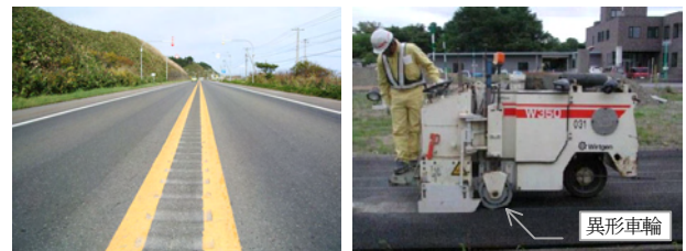
写真-1 ランブルストリップス（左）と施工機械（右）
