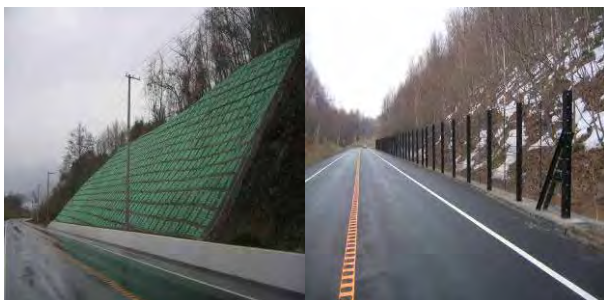
写真-5 落石・崩落対策後のR230 月浦法面
