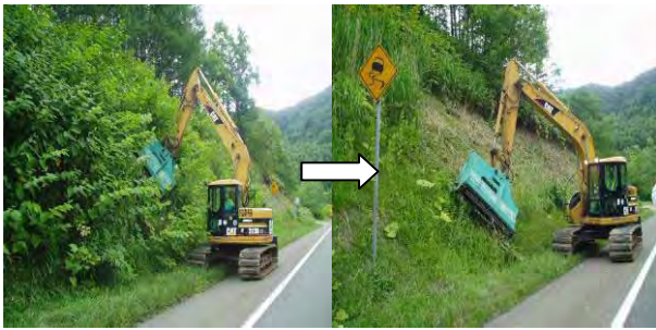
写真-4 草刈装置を使用した機械除草
