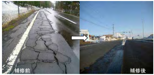
写真-7 R230 香川周辺の舗装補修
