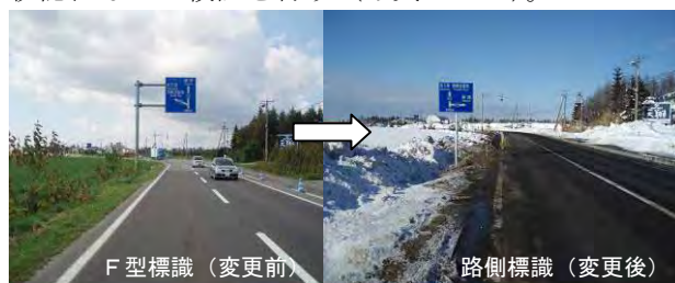
写真-12 大型標識から路側標識への変更
