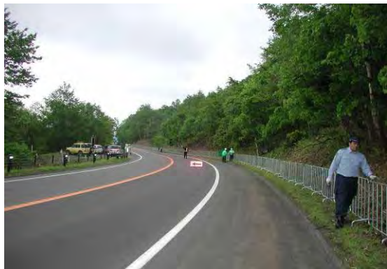
写真-10 警察による進入防止柵の設置状況
