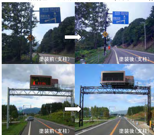
写真-11 景観色への塗装(支柱)
