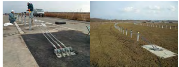
写真-7 端末部(左)とカーブ区間の施工状況(右)
