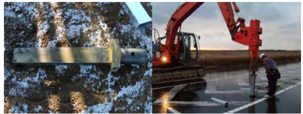
写真-6 作成したアタッチメント(左)と施工状況(右)
