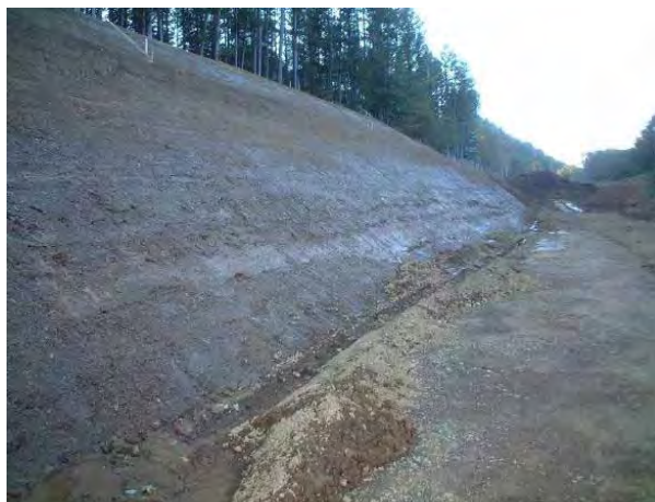
写真-2 施工直後の切土法面
