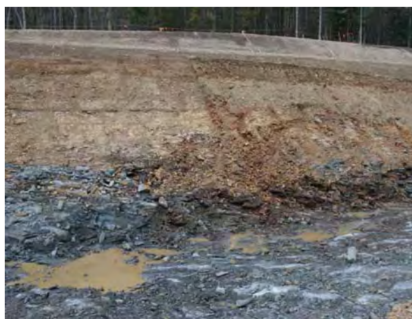
写真-3 施工直後の切土法面
