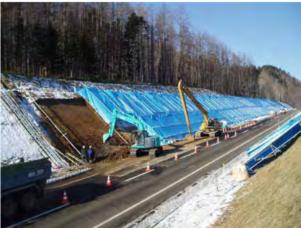
写真-8 防寒養生
