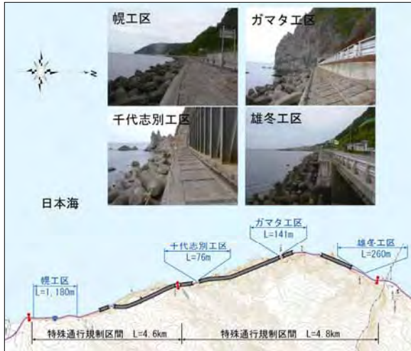
図-2 各工区の状況
