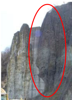
写真-1 実岩盤斜面
