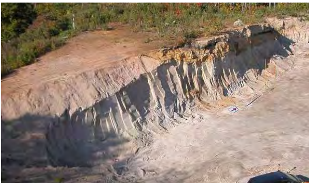
写真-3 計測対象斜面
