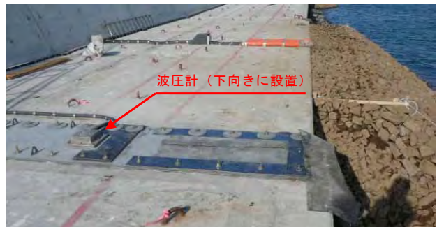
写真-2 ケーソン合端部 (天端面)
