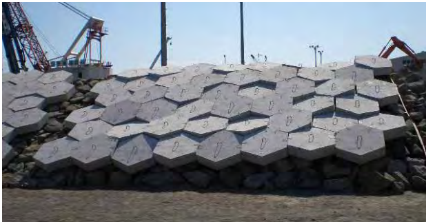
写真-3 コンクリートマット敷設試験状況
