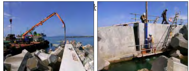
写真-5・6 コンクリート打設状況写真
