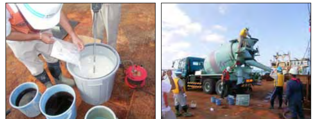
写真-7・8 混和剤添加状況写真
