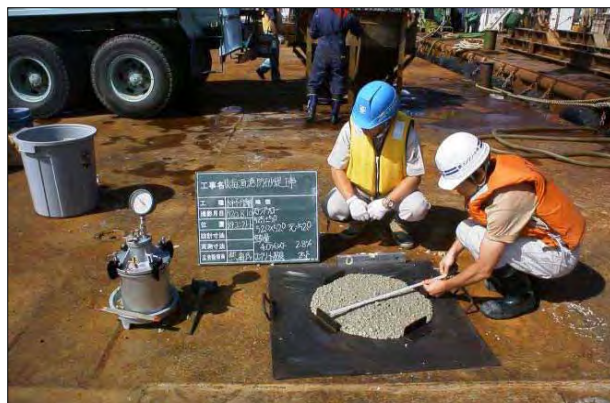
写真-11 スランプフロー試験状況
