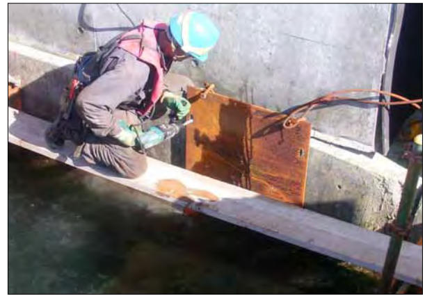
写真-4 型枠設置状況写真
