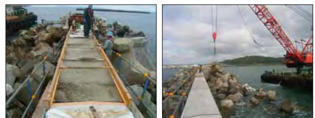
写真-9 上部工補修状況写真 写真-10 消波工状況写真
