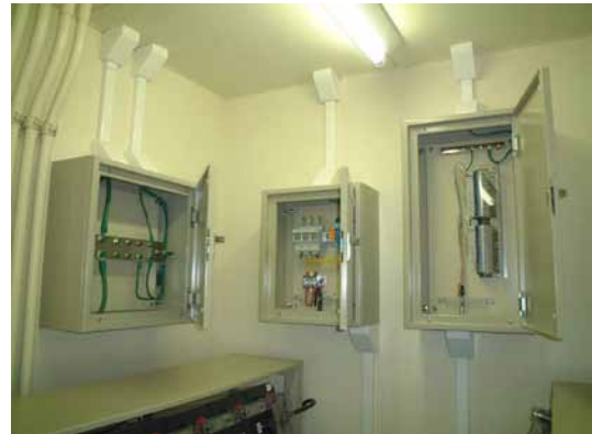
SPD盤・ボンディングバー盤の設置状況
