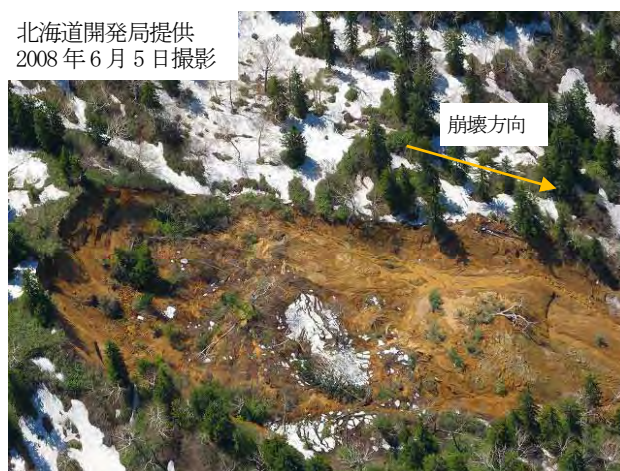
写真-5 崩壊地接近写真
