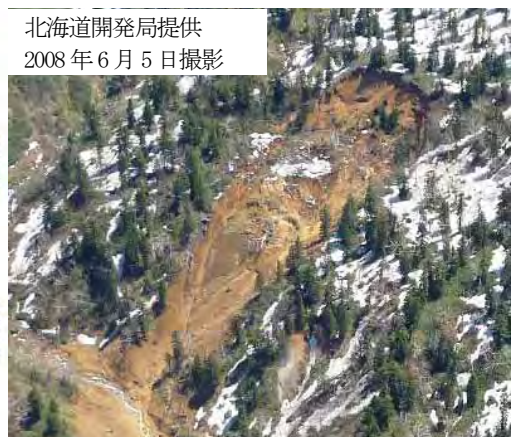
写真-1 斜面崩壊状況
