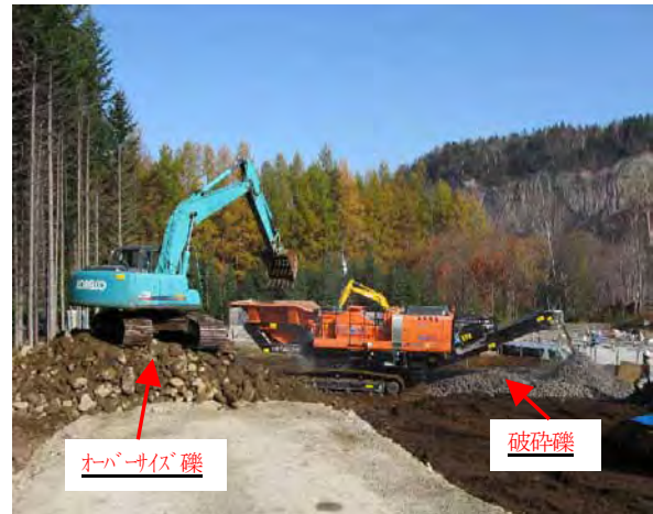
図-5 自走式クラッシャーによる礫破碎状況
