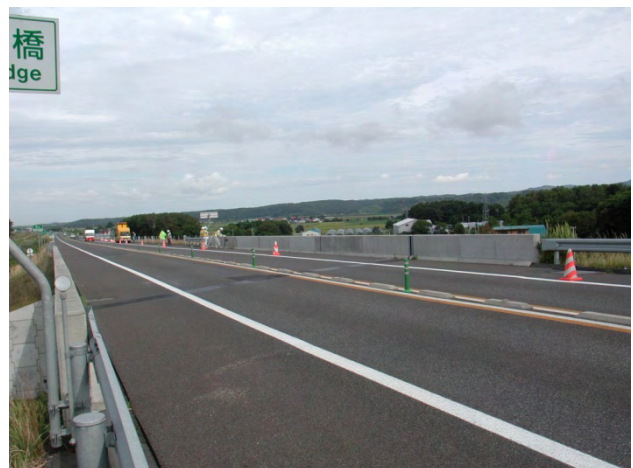
写真-1 イモッペ川橋全景
