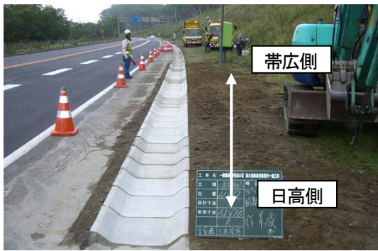
写真-2 6合目付近における試験施工状況
