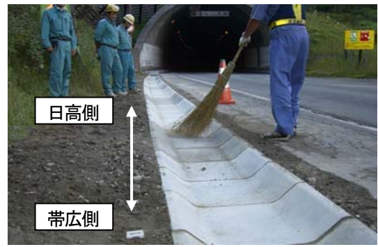
写真-3 7合目付近における試験施工状況
