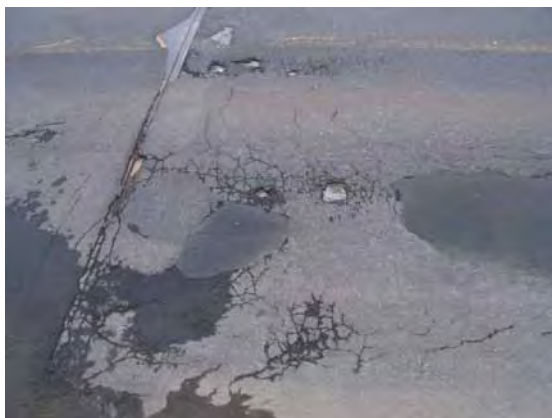
写真-2 路面状況
