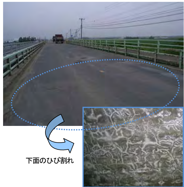
写真-1 路面全景と床版下面のひび割れ状況
