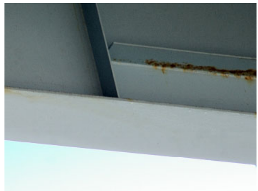
写真一8 エッジ部の状況写真 （「増塗り2層R有」さび発生評価：0%）
