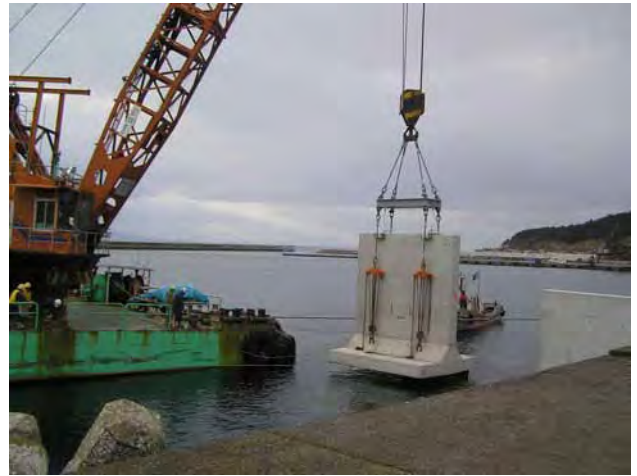
図-13 逆Tブロック吊上状況写真
