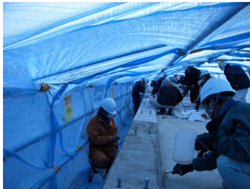
写真-3 表面含浸材の塗布状況 (2007年12月12日)
