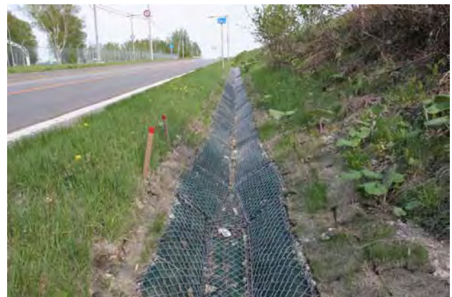
写真-1 浸透側溝 AタイプとBタイプの繋ぎ目部
