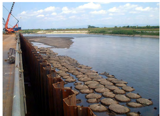
写真-3 洗掘防止工設置状況
