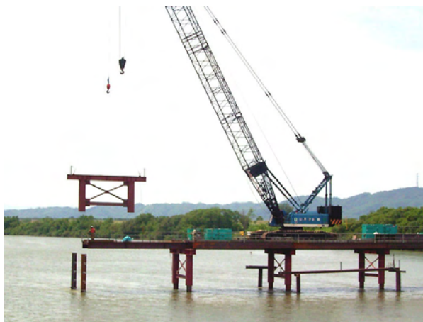
写真-1 作業構台の上部ジャケット施工状況
