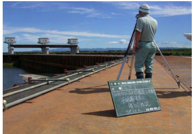
写真-2 二重締切の変位確認
