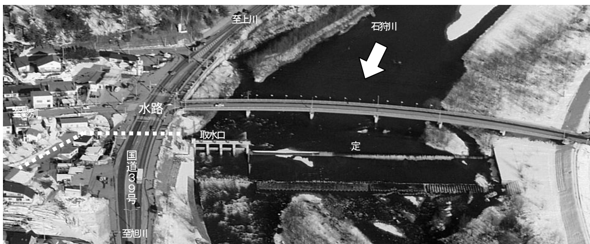
写真-1 旧石狩川愛別頭首工全景
