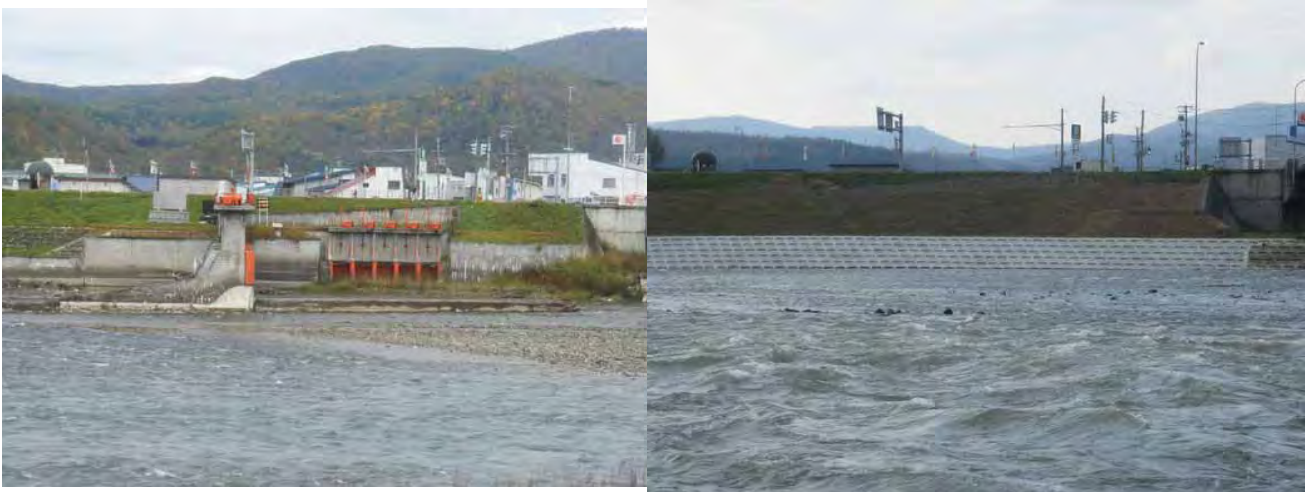
写真-2 施工前、施工後
