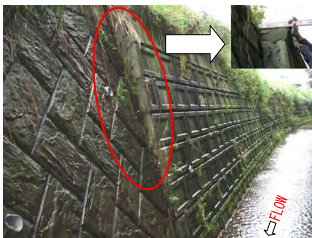
図-1 積ブロックの前傾
