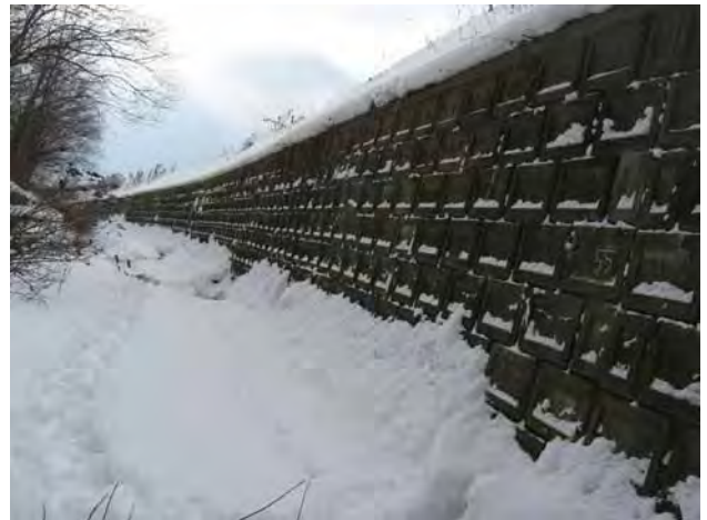
図-10 積雪状況(H20.2.13 定点15)
