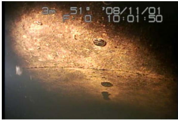
写真-3.3 水中ロボット管頂部の調査状況 (Fサイホン)
