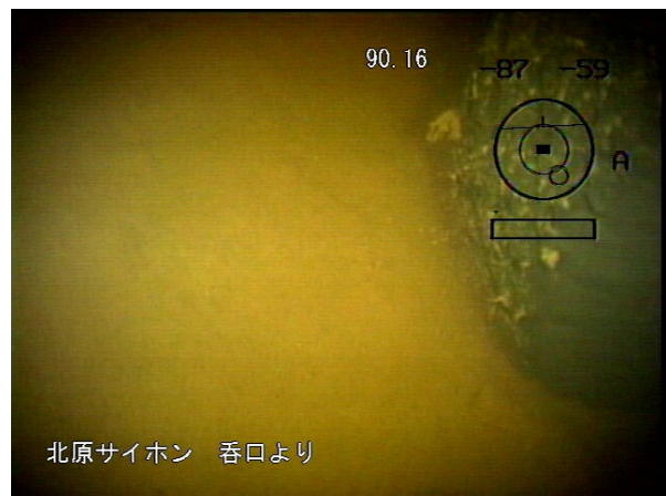
写真-3.2 自走ロボット残水有区間の管底部 (Cサイホン) の調査状況 (写真右上は自走ロボットのタイヤ)
